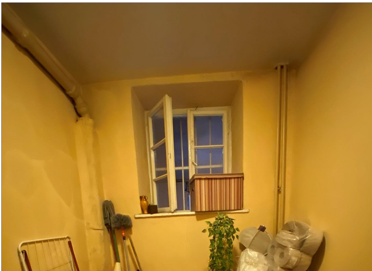
widok okienka drewnianego z parapetem od wnętrza budynku (w tle kraty)
